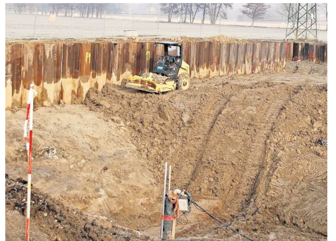
Rund 2,2 Millionen Euro hat vor zehn Jahren die Sanierung der ehemaligen Deponie „Alte Badeanstalt“ gekostet. 6000 Kubikmeter Boden wurden ausgehoben, davon mussten 4500 Kubikmeter entsorgt werden
