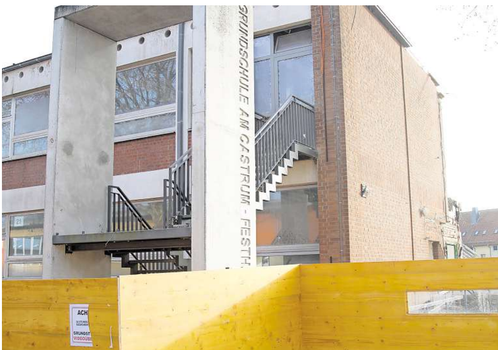
Millionenprojekt: In Gehrden wird die Grundschule Am Castrum neu gebaut. Damit soll die Ganztagsbetreuung gesichert werden. Die Kosten liegen bei mehr als 40 Millionen Euro
