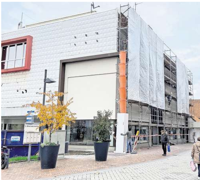
Auch außen passiert etwas: Im Obergeschoss des ehemaligen C&A-Gebäudes werden neue Fenster eingebaut, damit es auch dort Tageslicht gibt.
