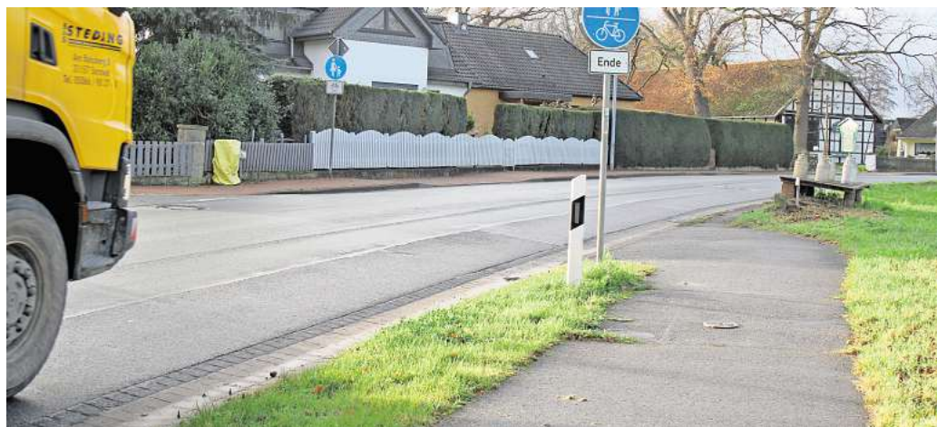
Calenberger Straße in Argstorf: Mitten in einer langgezogenen Kurve müssen Radfahrende vom Radweg auf die Straße wechseln. Ein Schutzstreifen und ein Überweg mit Mittelinsel sollen die Gefahrenstelle entschärfen. FOTO: STEPHAN HARTUNG
