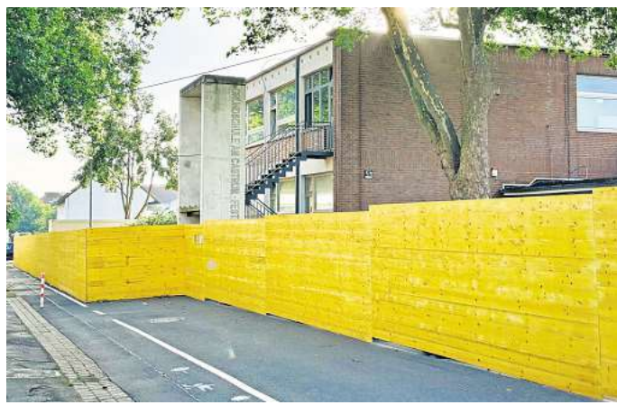
Gelber Bauzaun als Schutz: Die Tage der alten Grundschule Am Castrum sind gezählt. Das Gebäude wird zurzeit Stück für Stück abgerissen.
