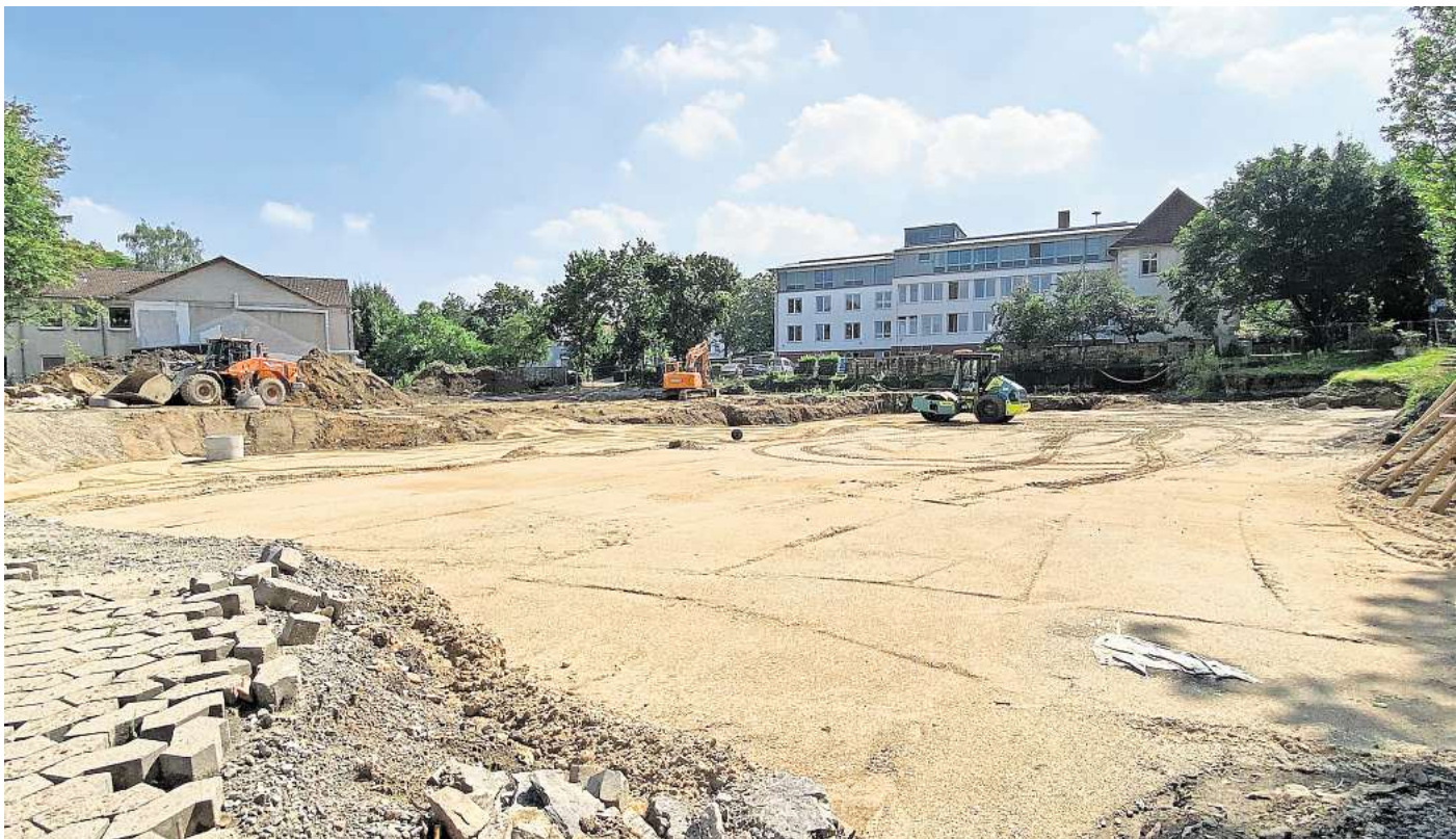
So sieht es aktuell auf der Baustelle aus: Schichtweise wird die Baugrube mit Schotter, Kies und Sand aufgefüllt. Bis auf den alten Ostflügel (hinten links) steht von der alten Wilhelm-Stedler-Schule nichts mehr. FOTO: JENNIFER KREBS
